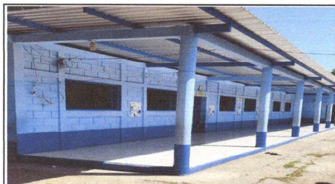
Foto 3: Sellado de grietas y fisuras en muros y columnas de 3 aulas y dirección, sustitución de lamina por lamina troquelada calibre 26 y soporte de metal
