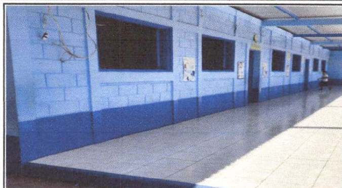
Foto 1: Sellado de grietas y fisuras en muros y columnas de 3 aulas y dirección
