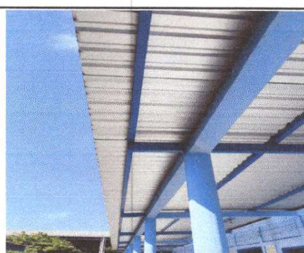
Foto 4: Sellado de grietas y fisuras en muros y columnas de 3 aulas y dirección, sustitución de lamina por lamina troquelada calibre 26 y soporte de metal
