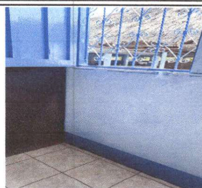
Foto 2: Sellado de grietas y fisuras en muros y columnas de 3 aulas y dirección
